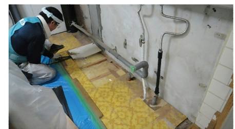
天井床下配管改修工事
