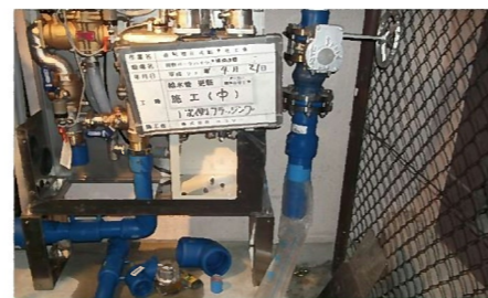
直結増圧ポンプユニット設置
